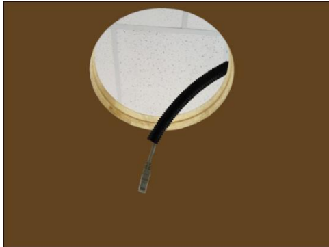
Using Flex Conduit
